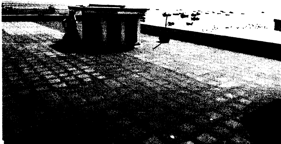
Foto N° 08: Impermeabilización de techos.
