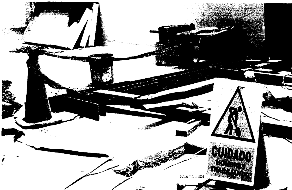
FOTO 9: uso de cintas de peligro y delimitación
